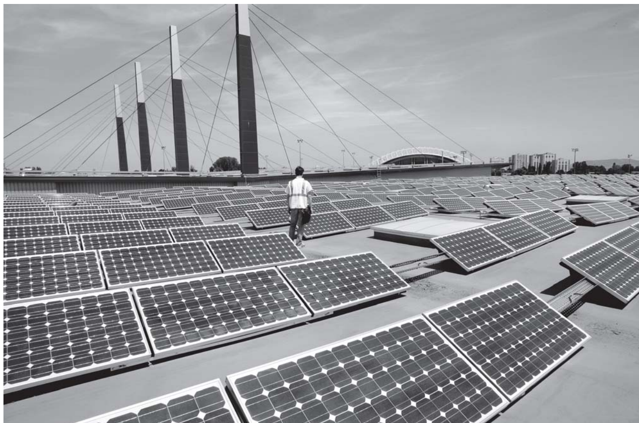
Pour la maintenance de son tramway, Clermont-Ferrand possède la plus grande surface de panneaux solaires de France. RICHARD DAMORET/RÉA
